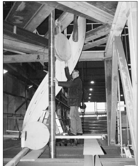
In der Werkhalle der Firma Schrader in Ennigerloh entsteht derzeit das Kunstwerk, das Ende des Jahres in Essen aufgestellt werden soll.
