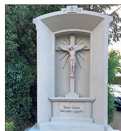
Bildhauer Stefan Lutterbeck aus Everswinkel hatte gerade erst den Bildstock restauriert. Risse wurden ausgebessert, Fugen geschlossen, der Beton geglättet und neu gestrichen.
